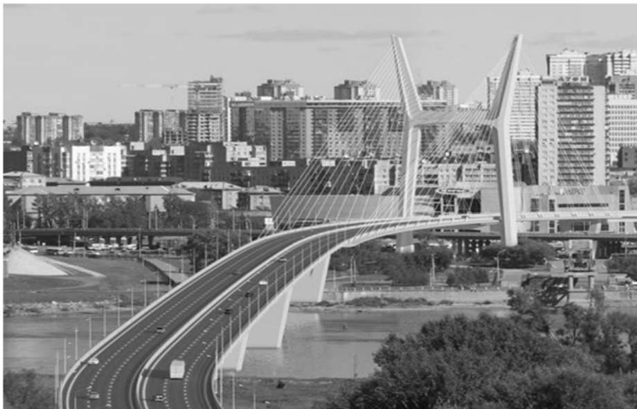
Мостовой переход через р. Обь в городе Новосибирске
